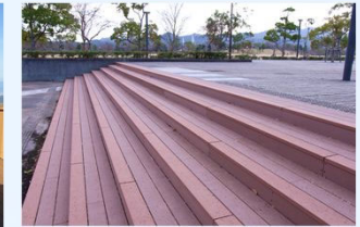
デッキ @鳴門ウチノ海総合公園
