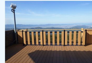
デッキ・フェンス・階段 @大川原高原展望台
