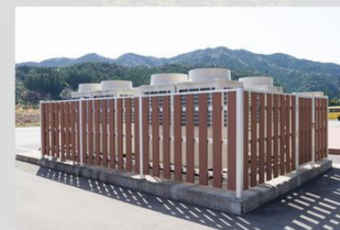
目隠しフェンス @那賀町林業ビジネスセンター
